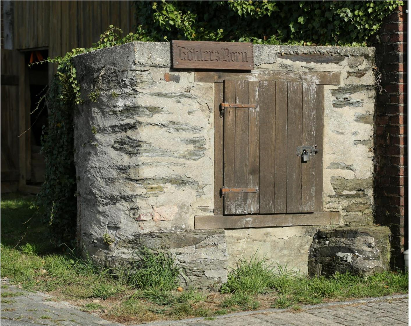
Eine Besonderheit des Brunnens ist die fehlende Dachkonstruktion. Stattdessen hat er eine schlichte Abdeckplatte. Diese war mal früher aus Naturstein und ist heute aus Beton.
